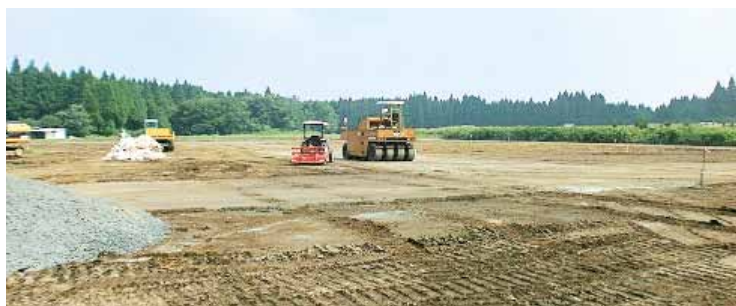
1.5ha の新原木置場を整備中 (7 月 10 日完成予定)
